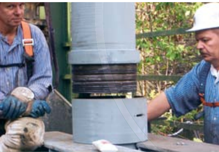
Einbau einer ZSM-Leitung
